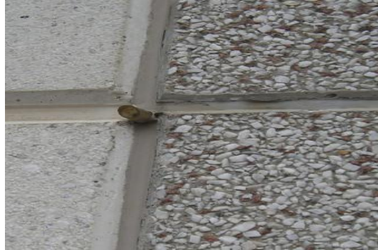
Kuva 13 Tuuletusurien tulo- ja poistoilma-aukko sandwich- elementtien liitoksessa
