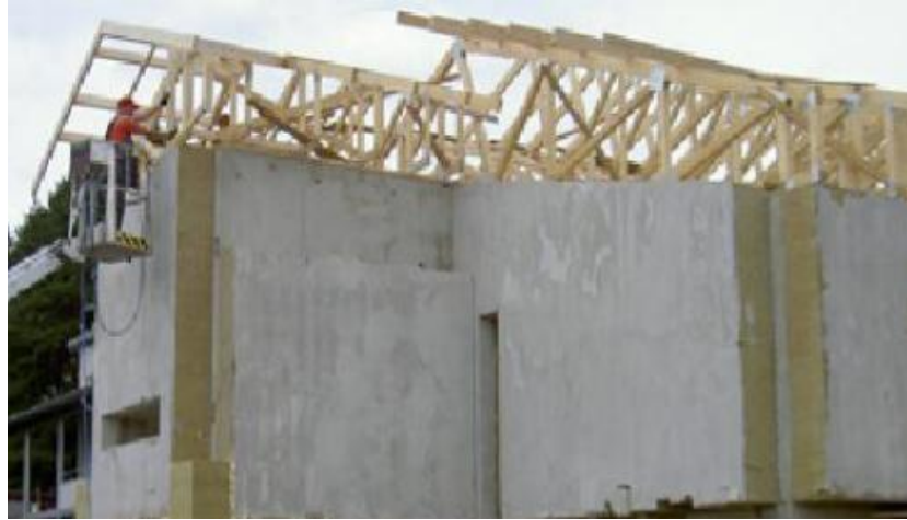
Kuva 48 Ohuteristerapatun seinärakenteen nurkkaliitoksen valmistaminen työmaalla. Kuvassa vasemmalla on aloitettu nurkkaliitoksen lämmöneristäminen ( www.paroc.com )
