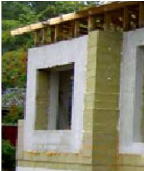
Kuva 49 Valmis nurkkaliitos, vailla rappausta ( www.paroc.com )
