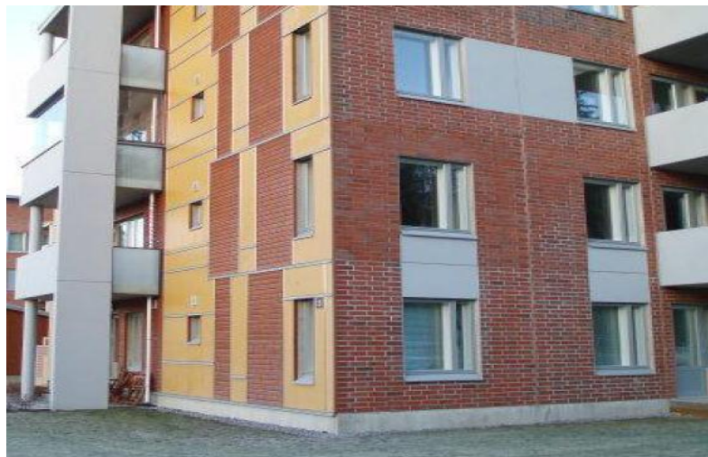
Kuva 1 Betonijulkisivuelementit asuinrakennuksen seinärakenteena
