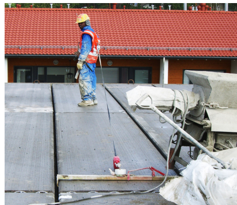
Ontelolaatta-asennuksessa suositellaan käytettävän henkilökohtaista putoamissuojausta.
