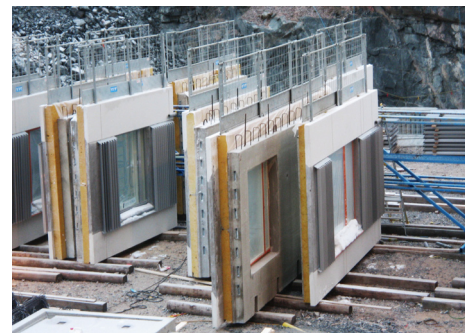
Hyvä käytäntö on kiinnittää kaiteet elementteihin jo ennen niiden paikalleen asentamista.
