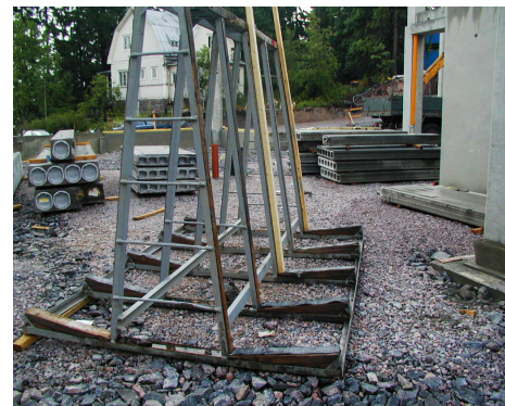
Seinäelementit voidaan varastoida työmaalla esimerkiksi A-pukkeihin. Elementit nostetaan A-pukeista pois vuorotellen kummaltakin puolelta, jotta telineen tasapaino säilyy.
