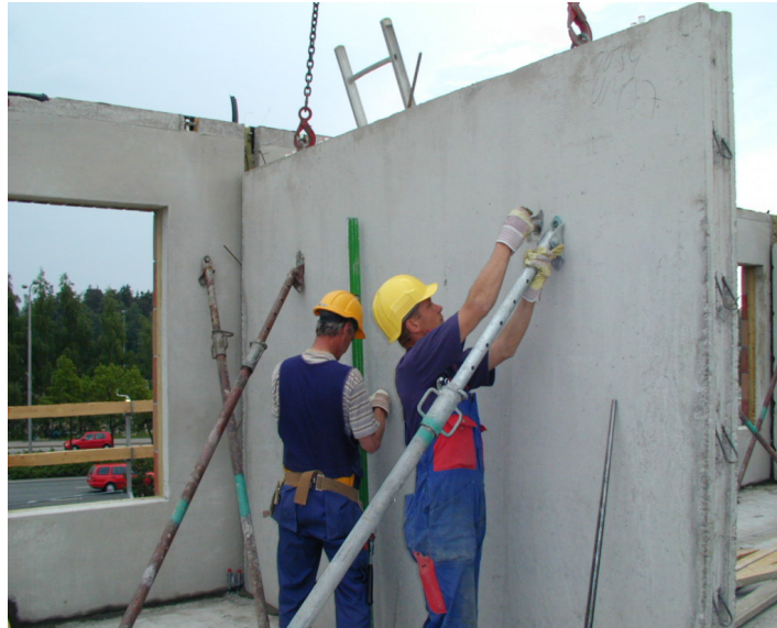
Kuva 19. Seinäelementin tukeminen. Nostoraksit irroitetaan vasta, kun elementti on tuettu.
