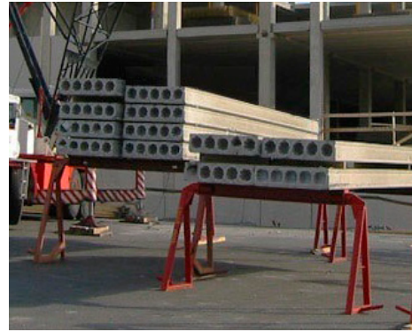
Ontelolaatat voidaan varastoida myös erillisten valmiskuormapukkien päälle.
