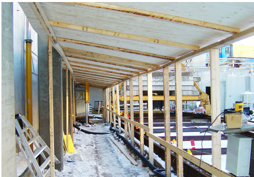
Kuva 6. Työmaan kulkureitit tulee olla järjestyksessä ja selvästi merkitty. Kulkureiteille ei varastoida tavaraa.
