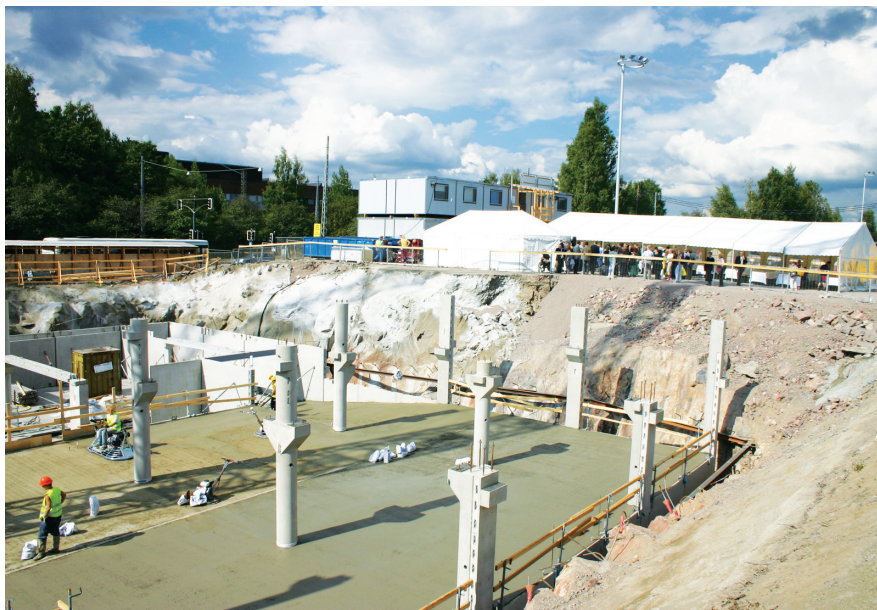
Kuva 7. Siistillä ja järjestyksessä olevalla työmaalla työskentely on kevyempää, turvallisempaa ja tuottavampaa.
