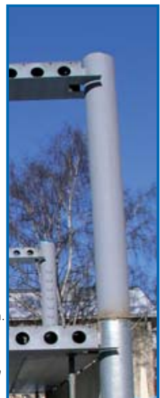
Kuva 9. Deltapalkki pyöreän pilarin kanssa
