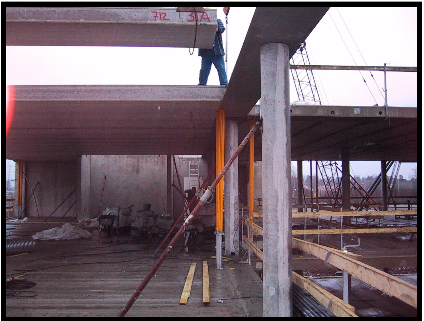
Kuva 16. Lujabeam-palkin asentaminen työmaalla ja työnaikainen tuenta.
