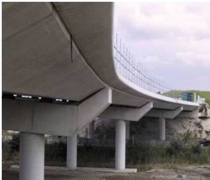
Kotelopalkkisilloja (valokuvat: Spanbeton BV, Hollanti)
