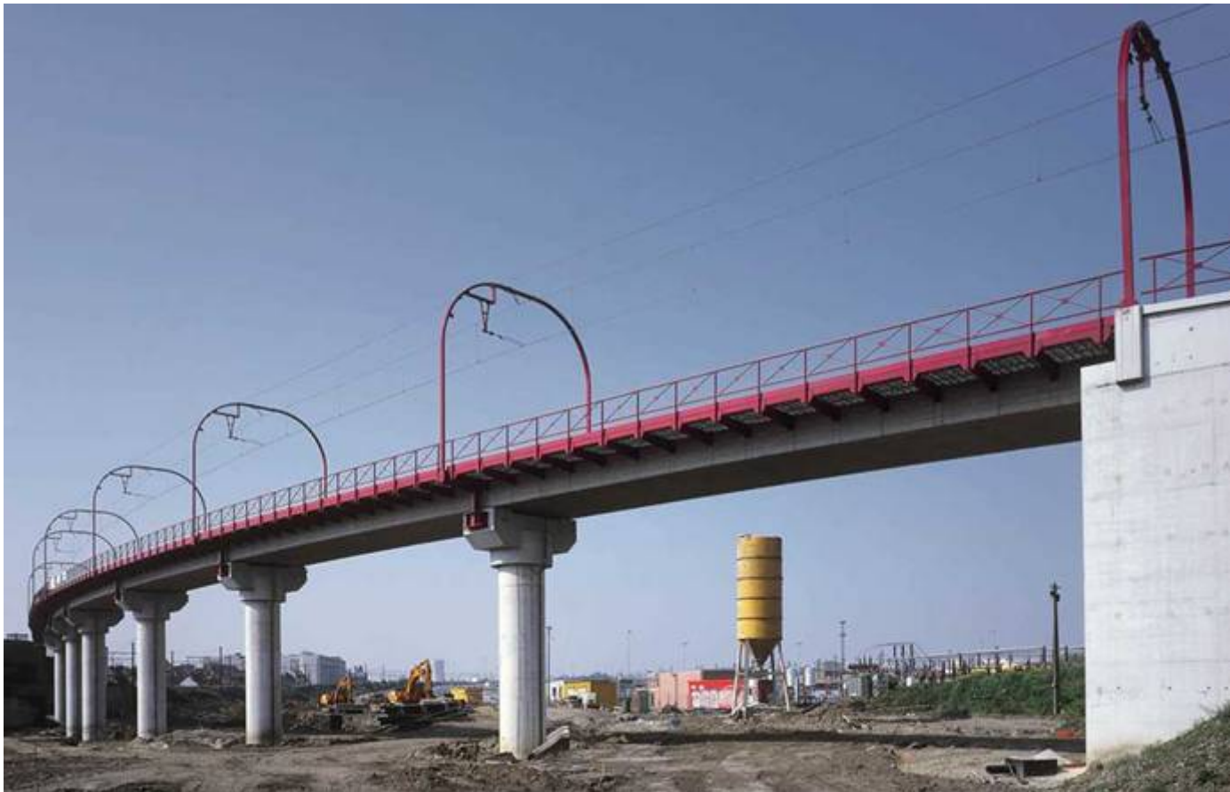
Rautatiesilta. Pilarit ja poikkipalkit teräsbetonielementtejä. Palkit jännitettyjä kouruelementtejä. Huolto- ja kävelykaista teräsrakenteinen. (valokuva: Ronveaux, Belgia)
