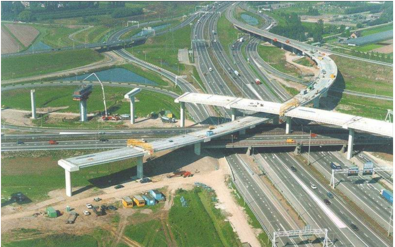
Sillan rakentaminen neljään tasoon jo käytössä olevan moottoritien eritasoliittymän päälle. (valokuva: Spanbeton BV, Hollanti)
