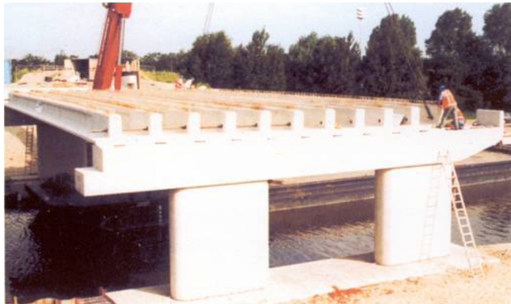
Palkkisilta, joka muodostuu jännitetyistä käännetyistä T-palkeista, ja niiden päälle valetusta laatasta. Jännevälialue 15 – 45 m. (valokuvat: Spanbeton BV, Hollanti)
