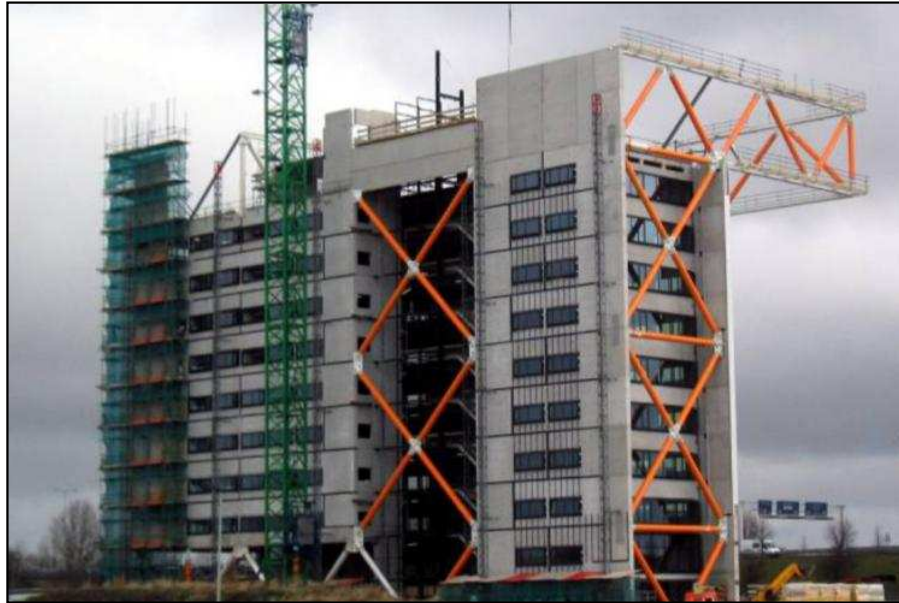
Kuva 2.17 Esimerkki ulkoisista jäykisteistä Hollanti /CORSMIT/ Asennusaikainen jäykistys ristikoidilla
