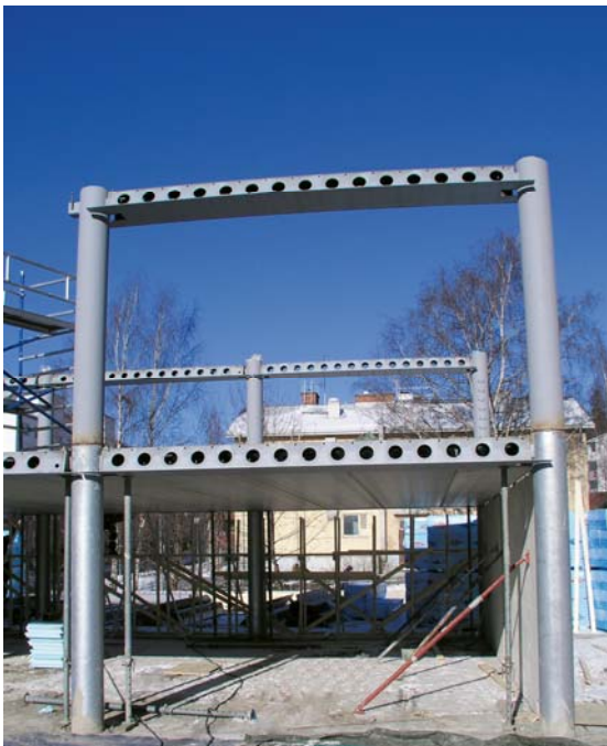
Kuva 3. Deltapalkki + ontelolaatat.
