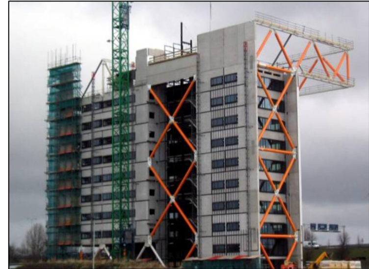
Esimerkki ulkoisista jäykisteistä Hollanti /CORSMIT/
