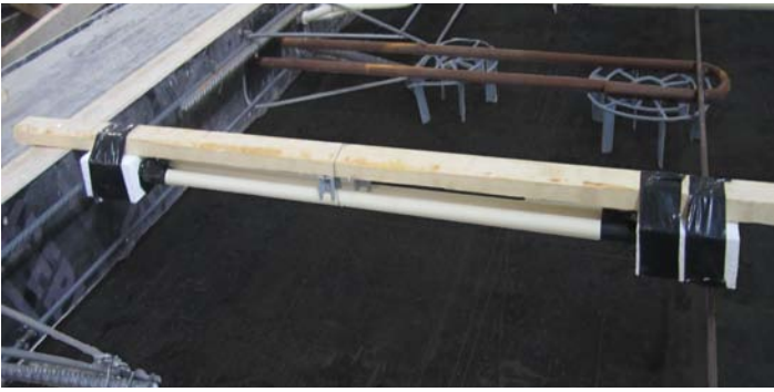
Kuva 19 Päätevaraukset WM2 tehty polystyreenillä. Varausten väliset sähköputket kiinnitetty lautaan rautalangalla ja raudoitekorokkeella.
