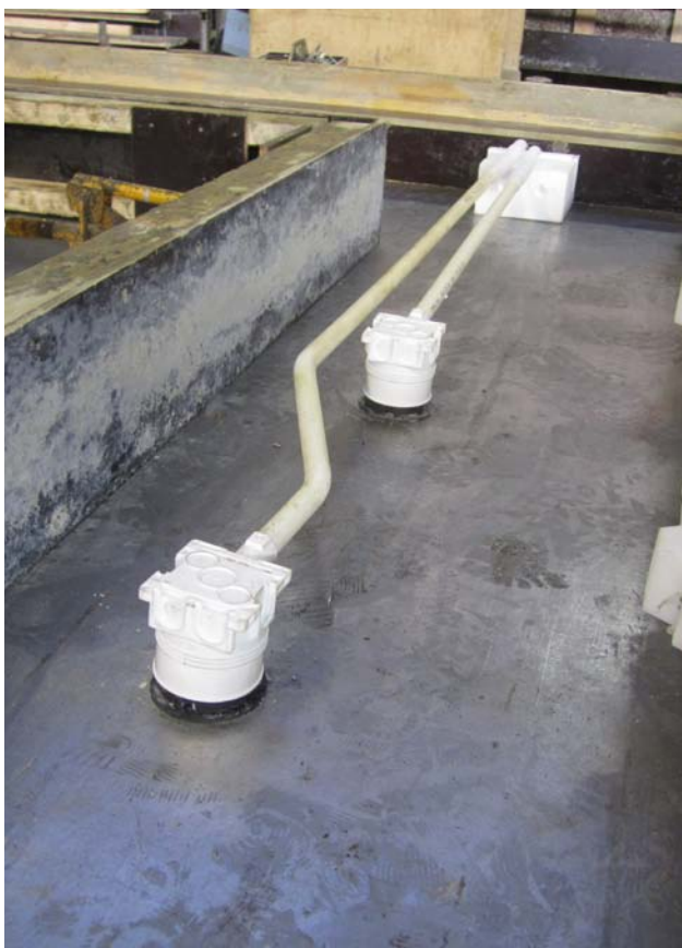
Kuva 27 Korotetut kojerasiat kiinnitetty magneetilla.
