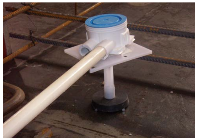
Kuva 4 Kojerasian tuki ja pohja ABB:n sekä Schneider Electricin rasiatyypeille.
