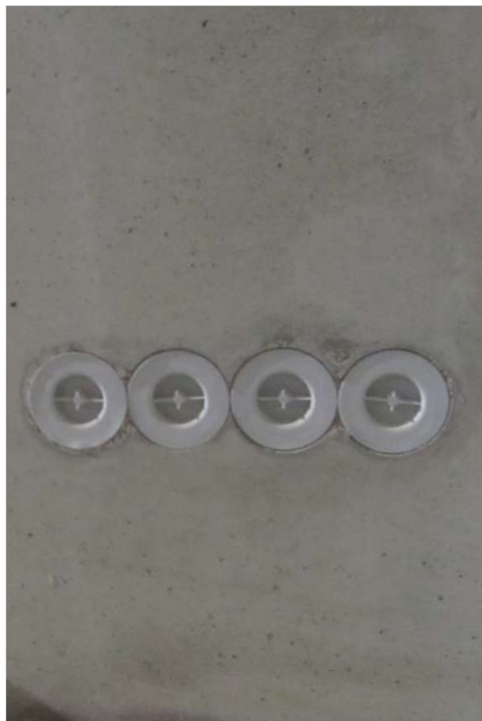
Kuva 34 Neljä kojerasiaa asennettuna.
