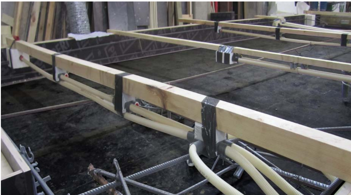
Kuva 20 Kojerasiat ja jakorasia kiinnitetty teipillä tukipuuun.
