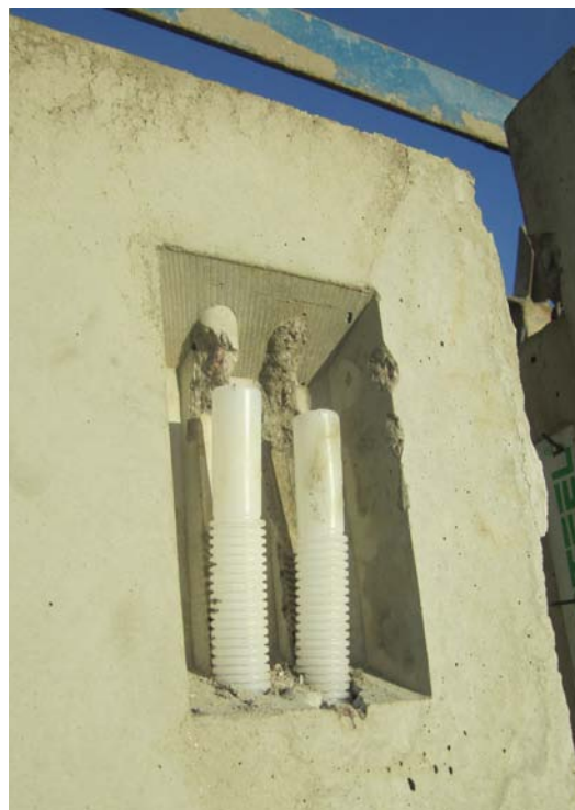
Kuva 30 Kuvan 29 varaus valmiissa elementissä. Taipuisat pääteholkit tart- tuvat betoniin, joten ne pitää irroittaa kuvan mukaisesti betonista.
