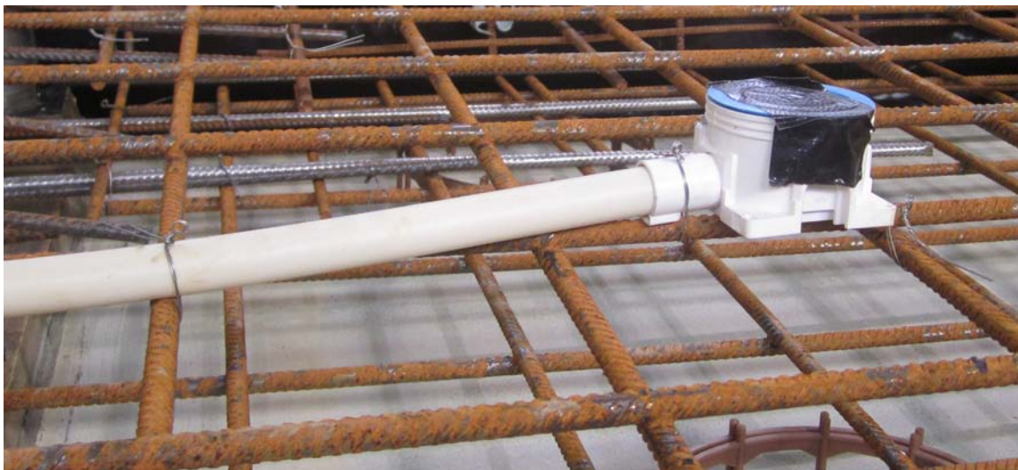
Kuva 26 Etupinnan kojerasia ja sähköputki kiinnitetty teräksiin.
