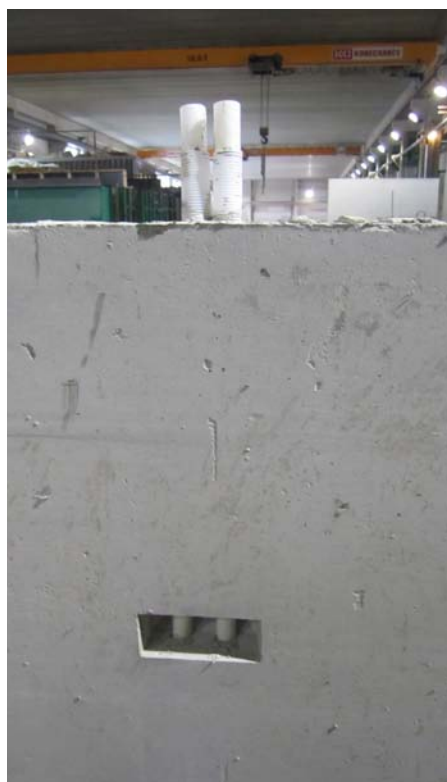
Kuva 32 Kiinnikkeen jälki paika- taan elementin pinnasta. Sähkö- putkissa käytetty taipuisia jatkoja.
