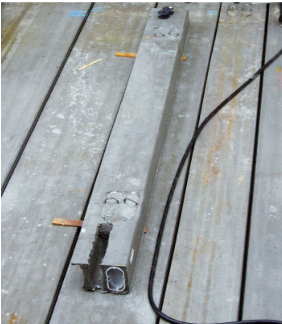
7 Kavennettuihin laattoihin suositellaan asennettavaksi nostolenkit.
