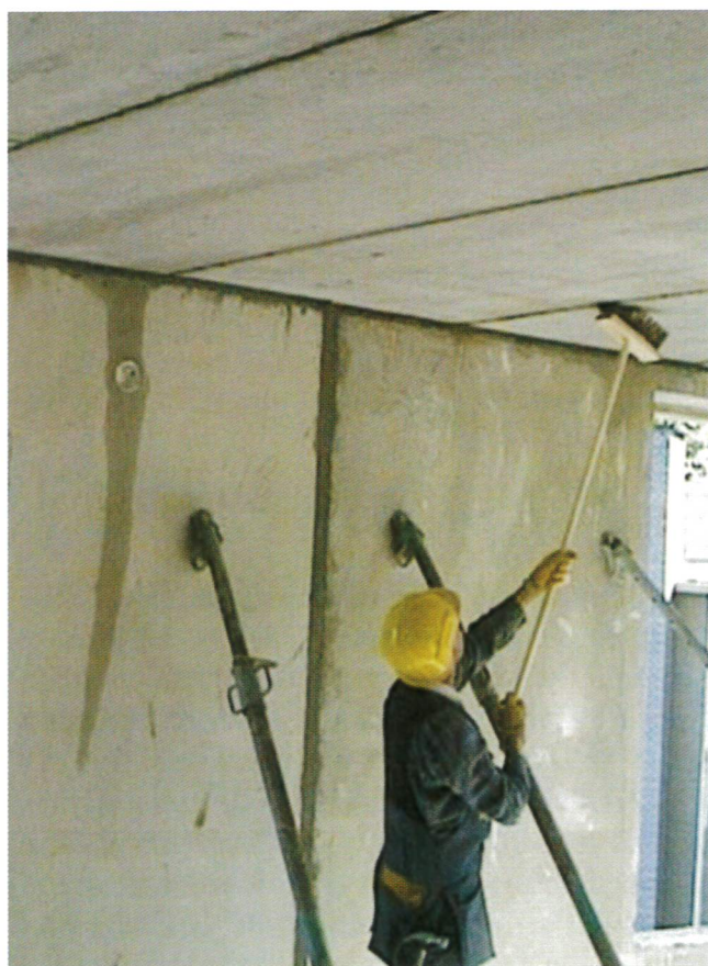
Kuva 2.9 Ontelolaattojen saumat harjataan alapuolelta puhtaaksi.
