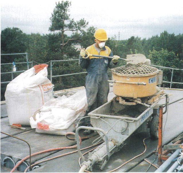
Kuva 3.3 Pystysaumabetonin valmistusta hollilla.
