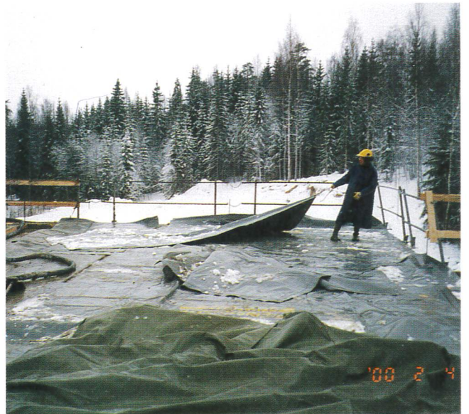
Kuva 2.13 Holvi suojataan lämpöpeitoilla ja presuilla heti valun jälkeen.
