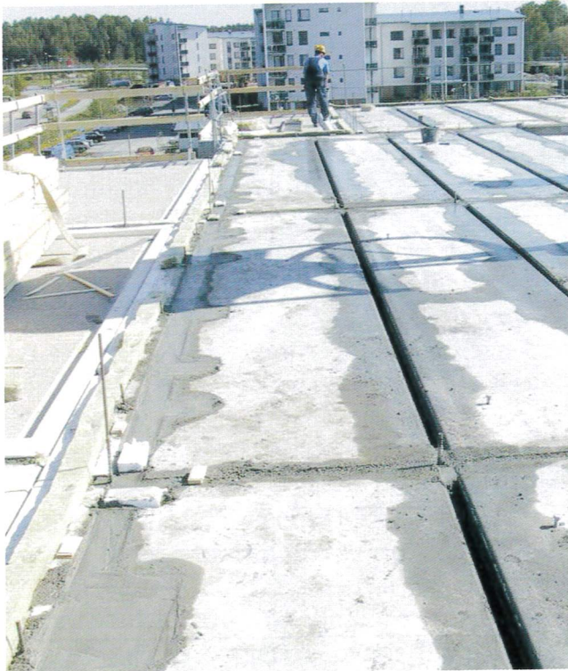
Kuva 2.1 Ontelolaataston saumaus kahtena eri työvaiheena.
