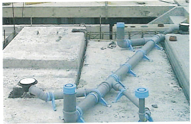
Kuva 2.15 Esivalmistetut viemärihaaroitukset ontelolaattojen päälle asennettuina.
