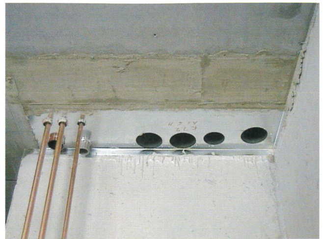
Kuva 2.5 Peltinen putkien läpivientiosa juotosvalun muottina.
