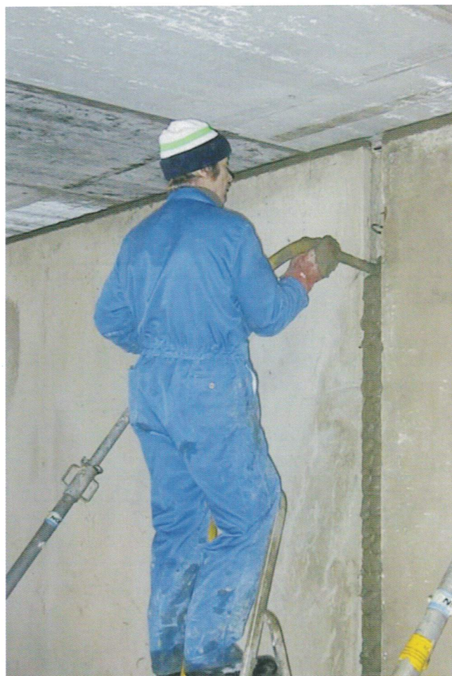
Kuva 3.2 Pystysauman betonointia pumppaamalla.
