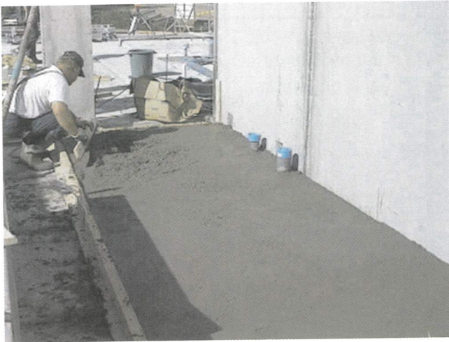
Kuva 2.14 Märkätilan lattian valaminen rungon nostamisen yhteydessä antaa betonin kuivumisella lisää aikaa.
