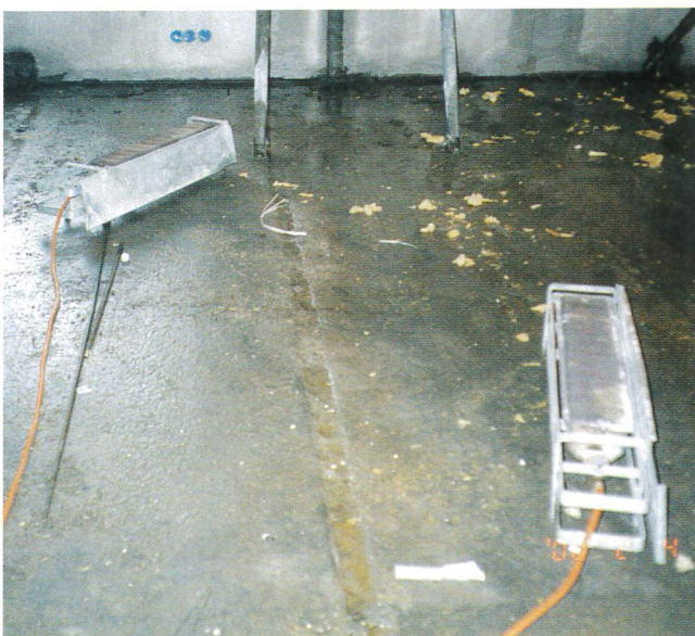
Kuva 2.11 Kaasutoimiset säteilylämmittimet suuntaavat lämmön holviin.
