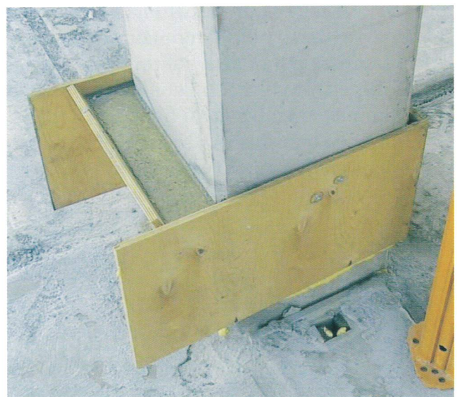
Kuva 4.1 Pilarijatkoksen painevalu.
