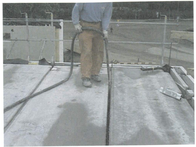
Kuva 2.8 Laataston saumapumppausta itsetiivistyvällä kuivabetonilla.
