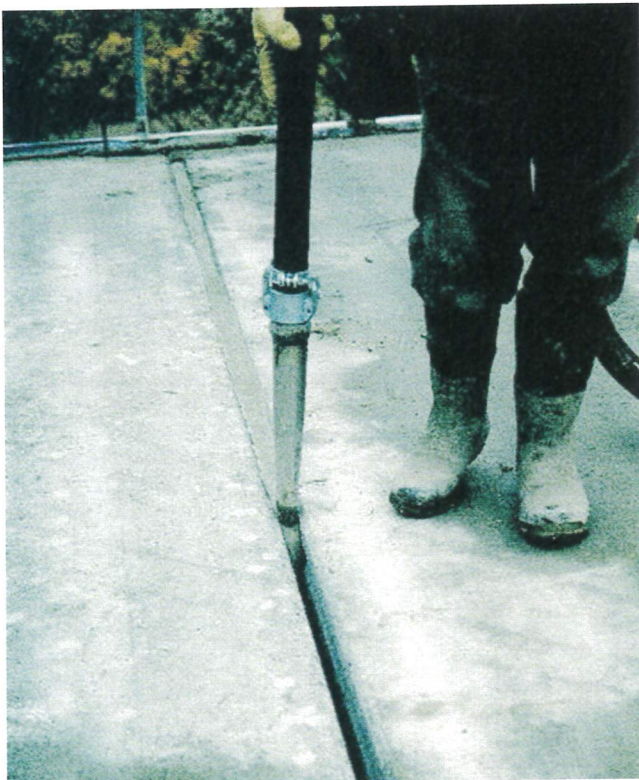
Kuva 2.7 Ontelolaataston saumaus pumppamalla.
