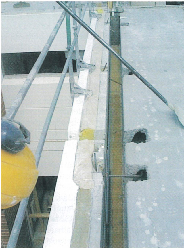
Kuva 2.2 Saumoihin asennetaan ennen juotosvalua tarvittavat saumateräkset, tukiraudat ja ontelotulppaukset.
