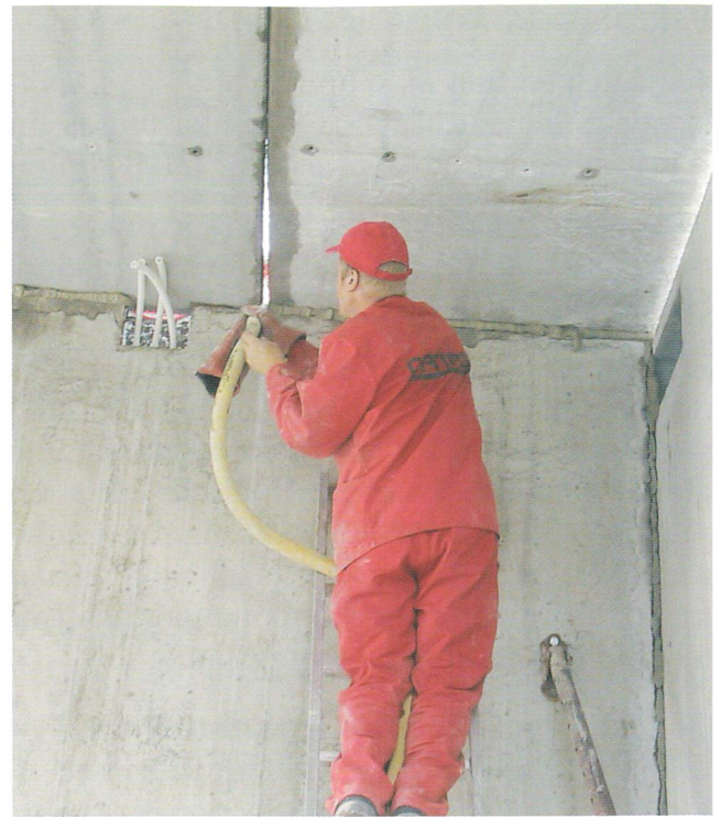
Kuva 3.4 Vaakasauman betonointi pumppaamalla.
