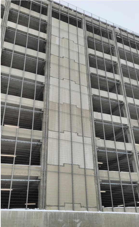
Kuva 5.7: Betonielementtien vaakaliitos betonivaarnalla
