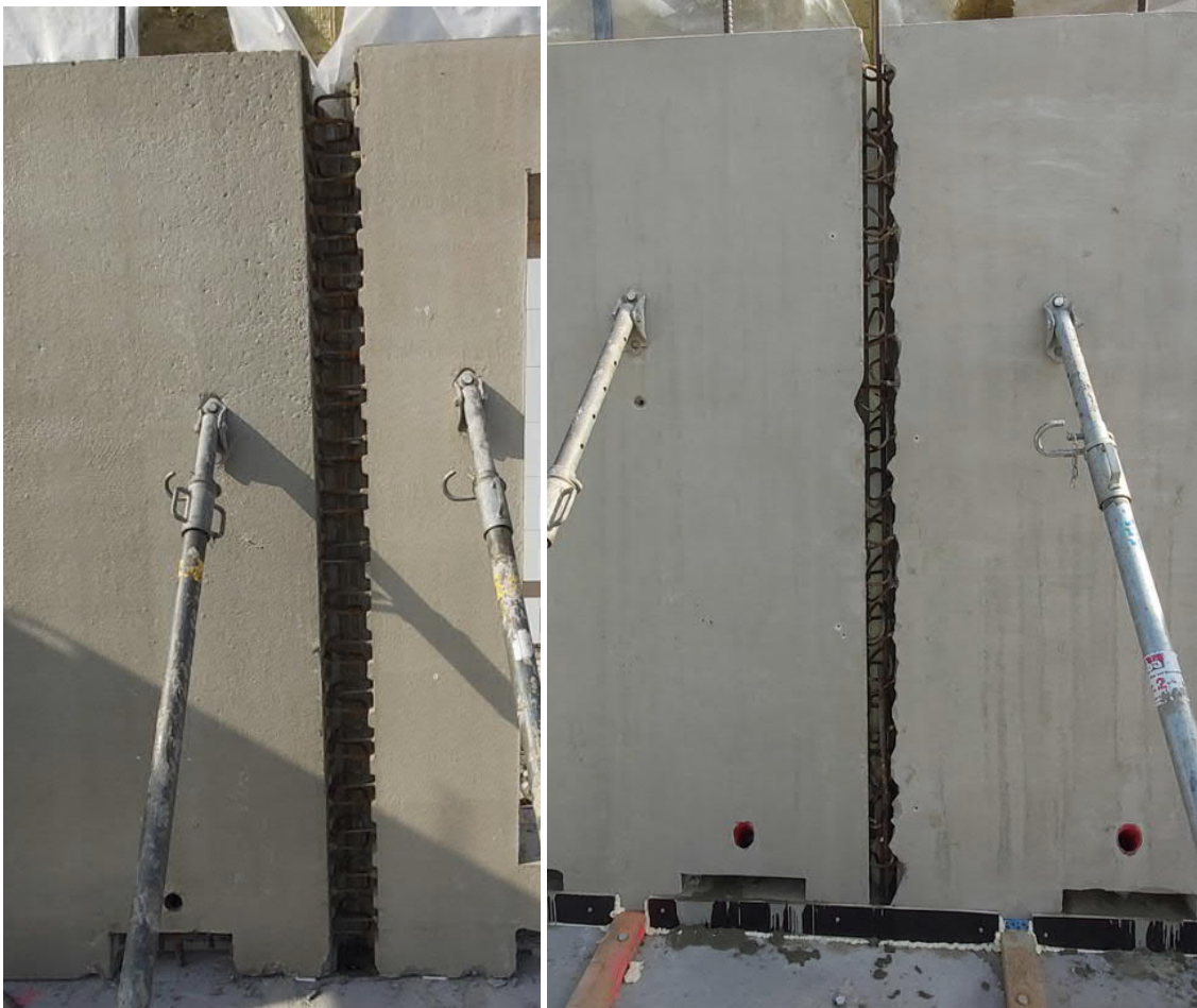
Kuva 2.9: Vasemmanpuoleisessa kuvassa lenkkien limitykset ovat suunnitelmien mukaisesti. Oikeanpuoleisessa kuvassa lenkit törmäävät päittäin.
