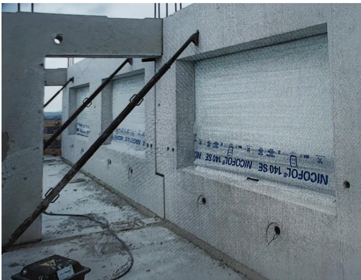
Kuva 2.10: Pystysauman lovipääliitos ulkoseinäelementissä (Fib Bulletin 74, 2014, s. 108)
